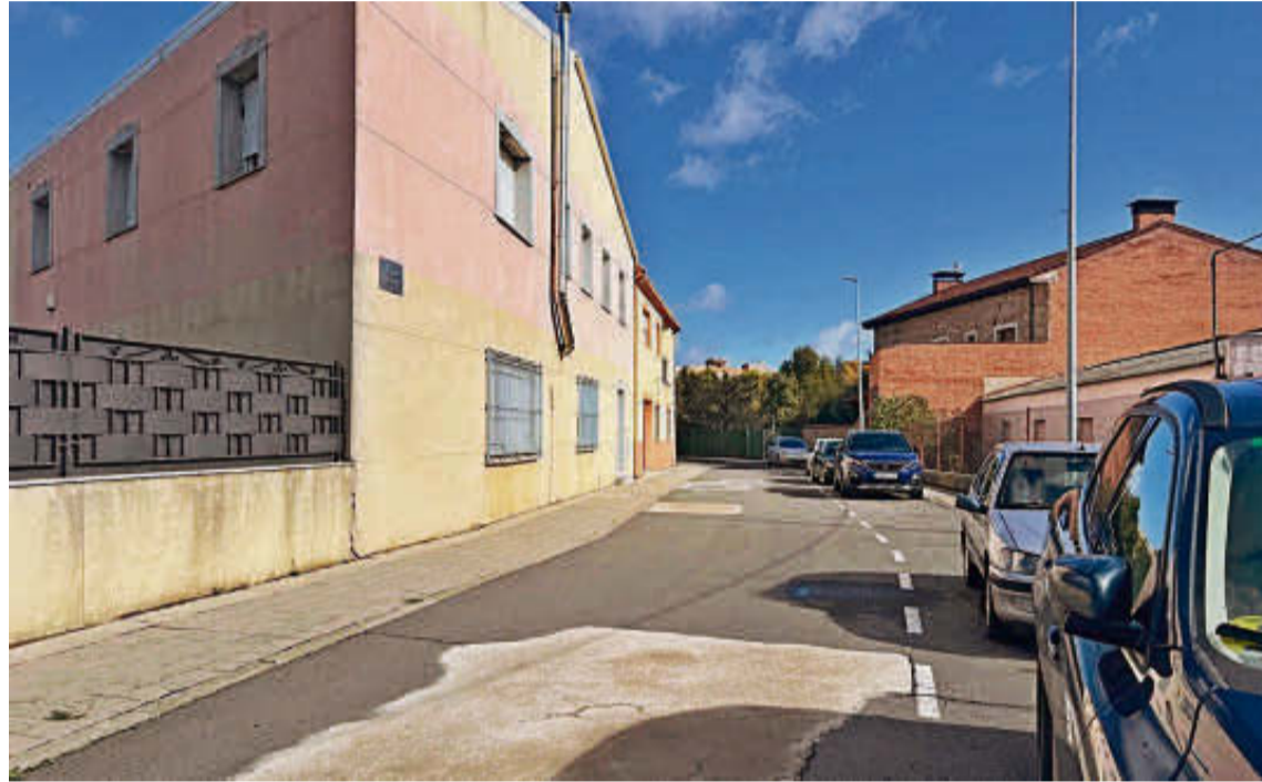
La calle Joaquín Gonzalo de Carbajosa de la Sagrada. EÑE
