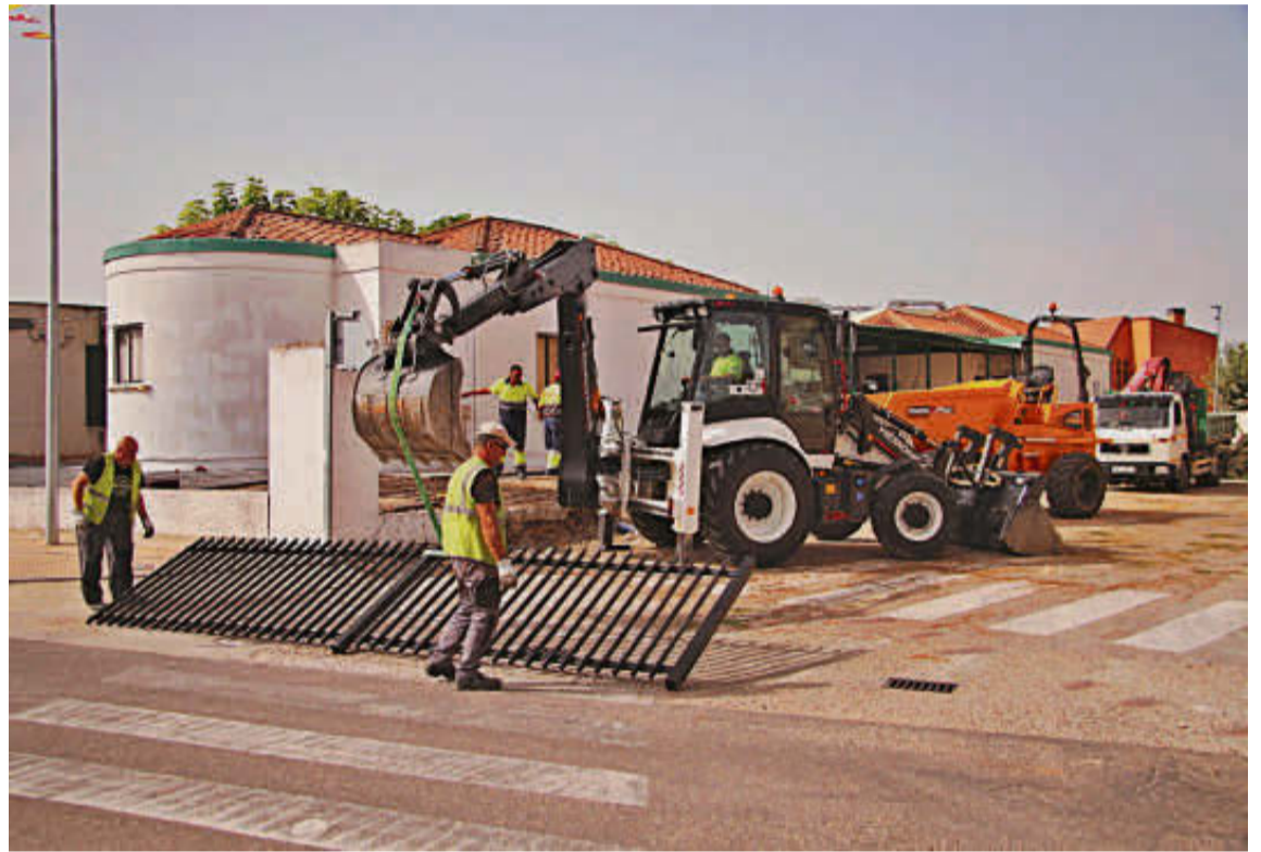
Los operarios trabajan en la mejora de la seguridad en el acceso al colegio de Castellanos. EÑE
