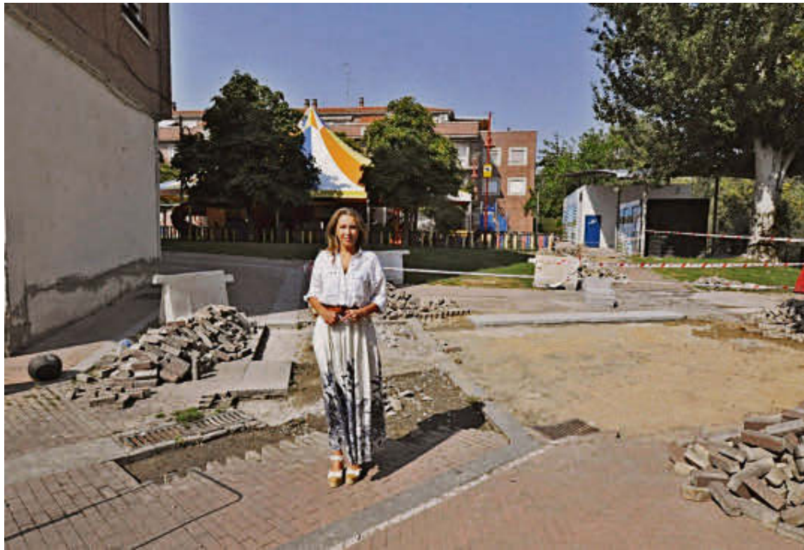
La edil Marta Labrador en las obras de la plaza del Ángel en Santa Marta. EÑE
