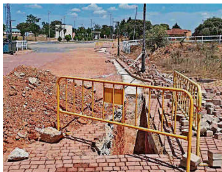
Inicio de las obras en el suministro de agua en Carrascal. EÑE
