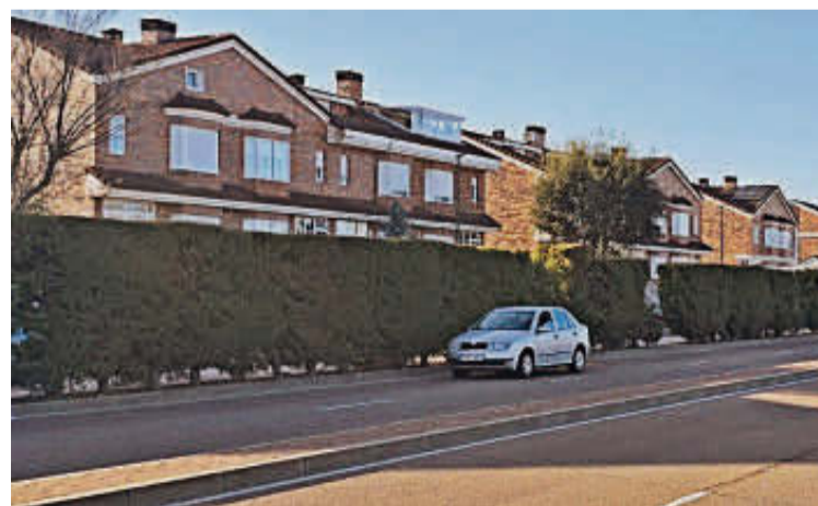
Pantallas acústicas ya existentes en la avenida de la Serna. EÑE
