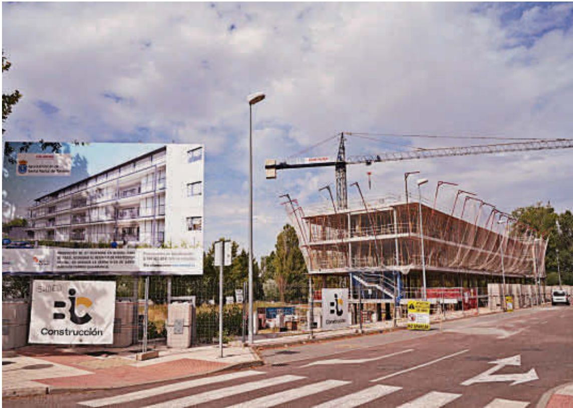
Construcción de las 27 viviendas públicas para jóvenes en la avenida de La Serna de Santa Marta. FOTOS:EÑE
