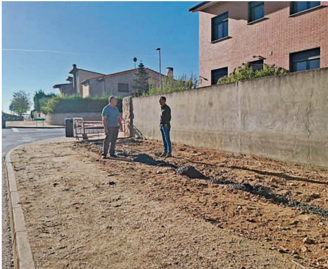
El concejal de Obras y el alcalde de Carbajosa de la Sagrada en la zona de actuación en Albahonda I. EÑE
