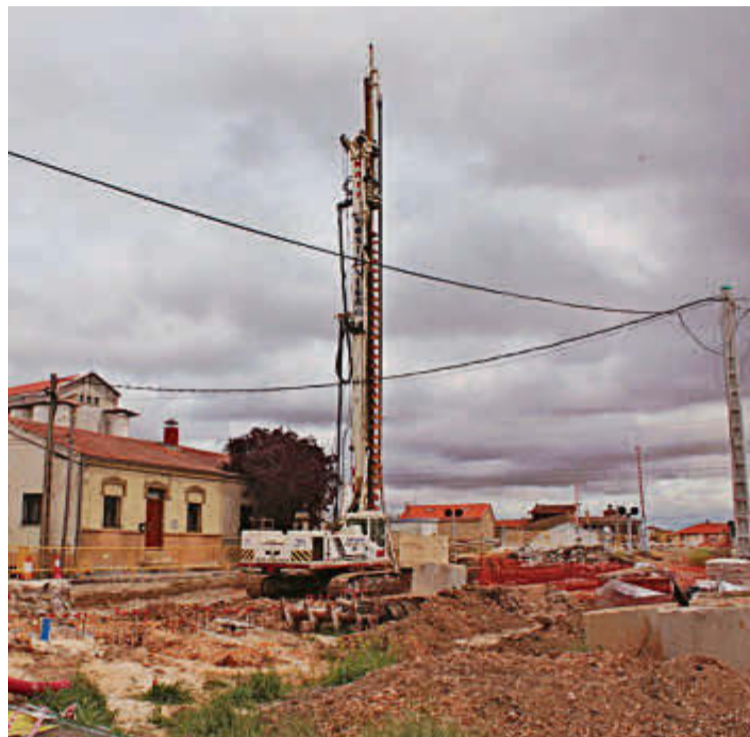
La maquinaria en la obra del túnel de Gomecello hace dos meses. | EÑE
