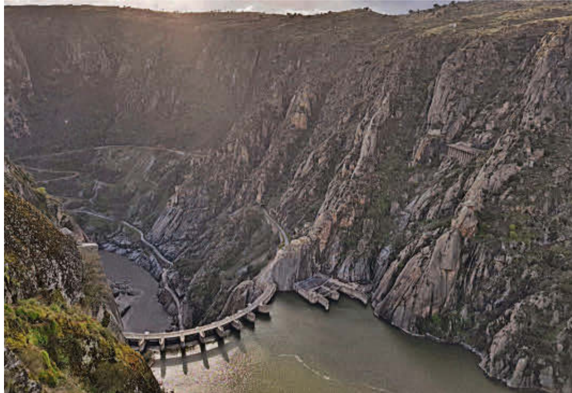
Presas de Aldeadávila de la Ribera, atractivo turístico y gran obra de ingeniería. IBERDROLA
