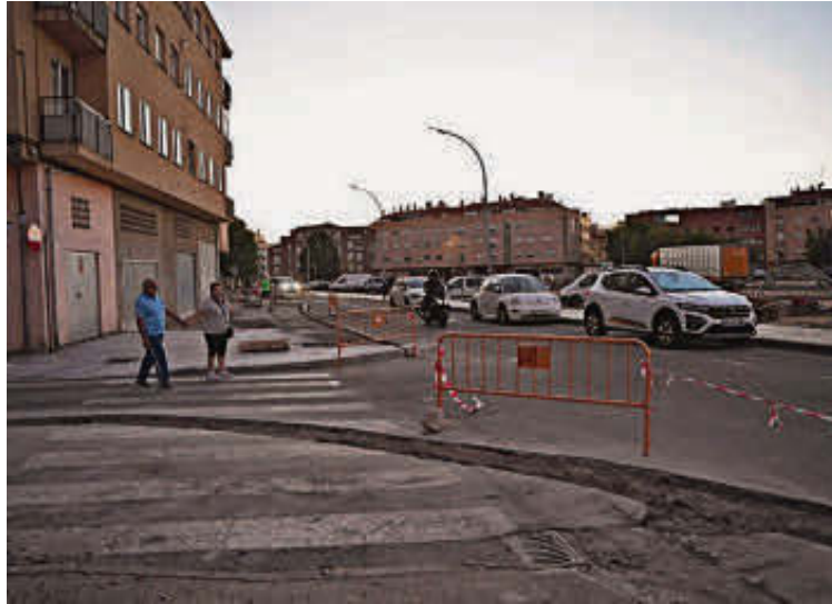
Aceras en obras en la calle Doña Eloya de Santa Marta. EÑE
