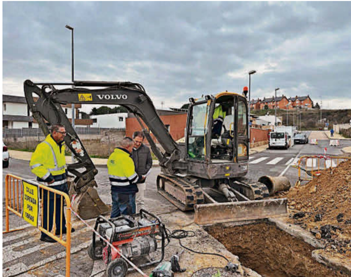
Obras en el paseo Fonseca de Villamayor para instalar dos nuevos pozos en la red de pluviales. EÑE
