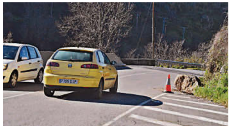
Imagen del tramo señalizado por la caída de una piedra en Béjar.
