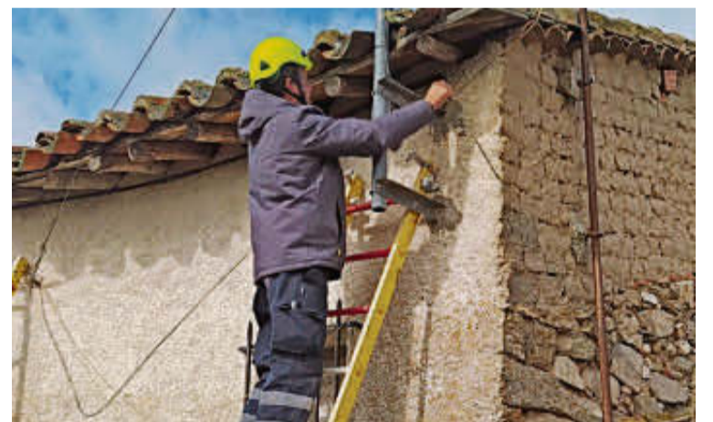
Un operario instalando el cableado en Añoover de Tormes. EÑE
