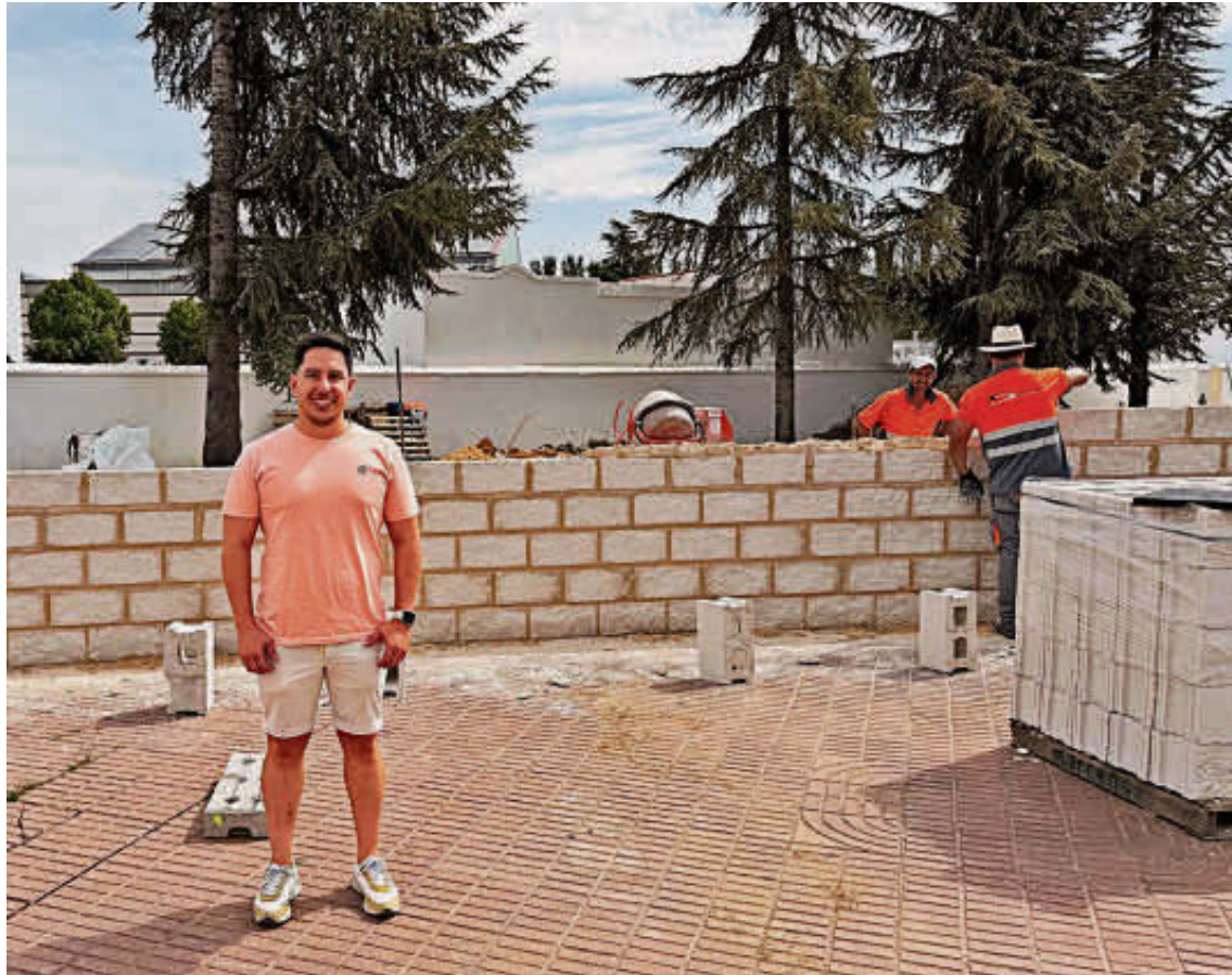
El edil Jorge Valiente, en la zona de ampliación del camposanto. EÑE
