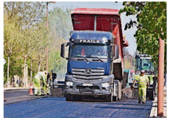
Operarios trabajan en las mejoras de la avenida de Madrid. EÑE
