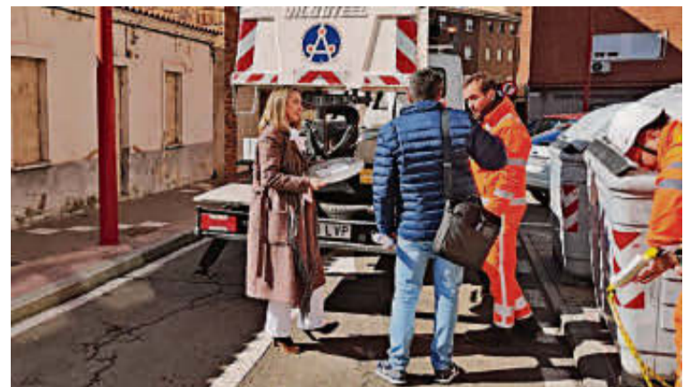
La edil Marta Labrador, con los operarios del cambio de luminarias. EÑE
