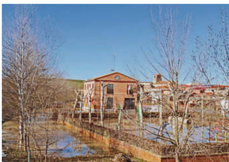
Parte de la localidad de Peñarandilla inundada de agua. HOLGUERA
