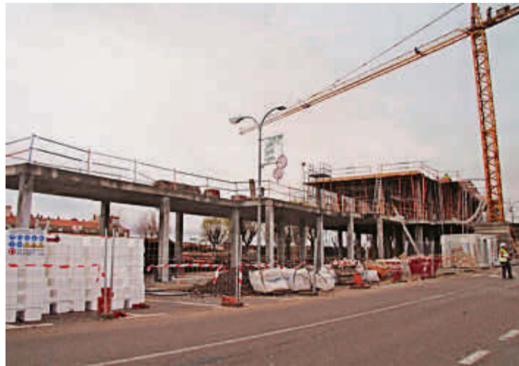
Estructura del nuevo edificio de servicio de la piscina estival de Villares. | EÑE
