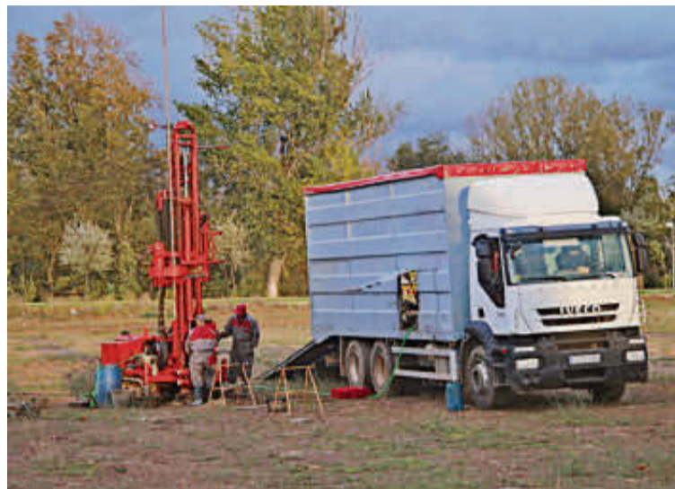
Los trabajos en la parcela del futuro Centro de Emprendimiento. EÑE
