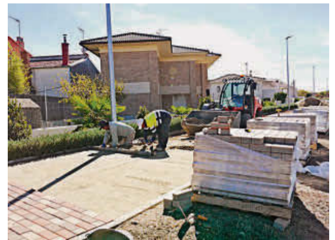
Los operarios colocando un tramo de adoquinado. EÑE
