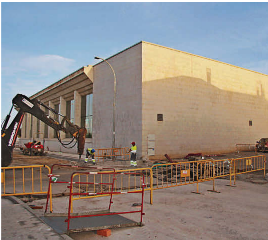
El Consistorio de Villares de la Reina está reurbanizando el entorno de la piscina climatizada. FOTOS: EÑE
