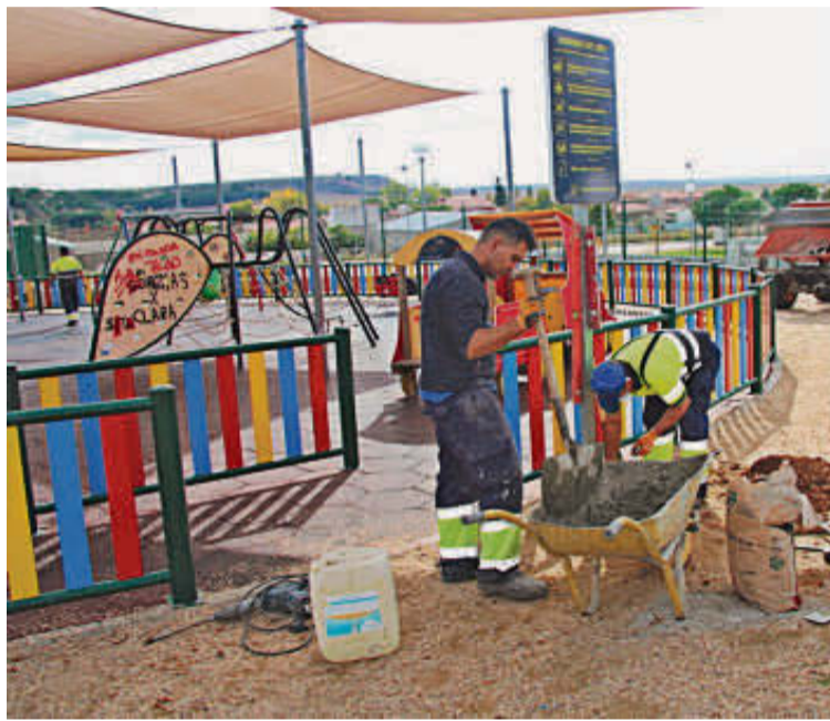
Los operarios municipales iniciando las reparaciones en el parque. | EÑE
