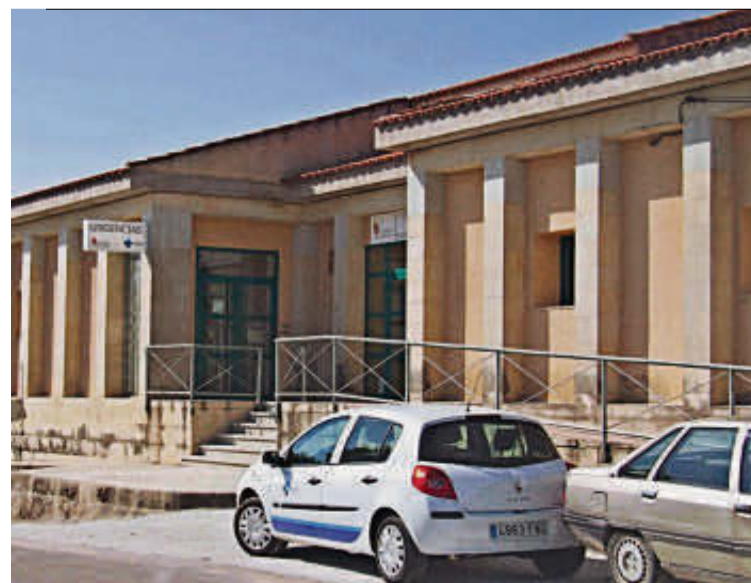
Exterior del centro de salud de Fuentes de Oñoro. | ARCHIVO
