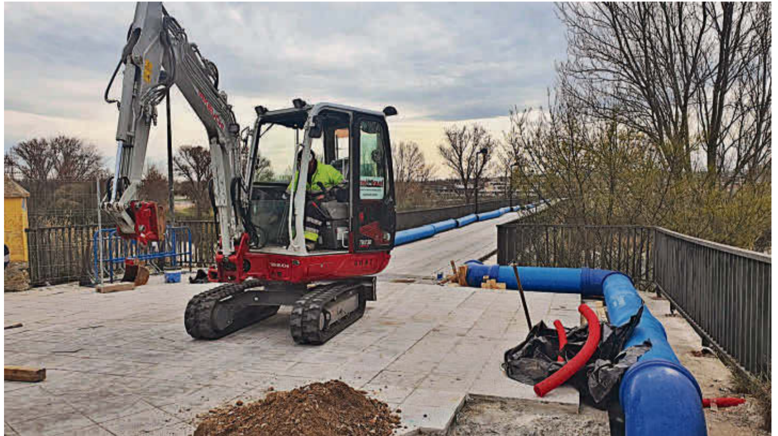
Los operarios que llevan a cabo la instalación de la nueva tubería de agua potable ya han instalado el primer tramo. REP. GRÁFICO: EÑE
