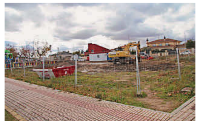
Nueva ubicación en Aldeaseca para la fiesta de San Blas. La pedanía de Villares de la Reina estrenará ubicación para las actividades de San Blas. En concreto la carpa de las actividades en Aldeaseca de Armuña se instalará en la parcela que acogerá el futuro recinto deportivo y que ya se está acondicionando. | EÑE
