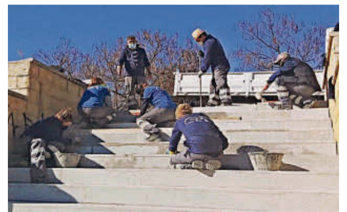
Renovación en El Soto de Aldeatejada. Los alumnos del taller de empleo de la localidad de Aldeatejada están completando la obra de renovación de las escaleras de la urbanización El Soto que comunican la zona de la pista de tenis con las calles de la zona más alta del espacio residencial. | EÑE
