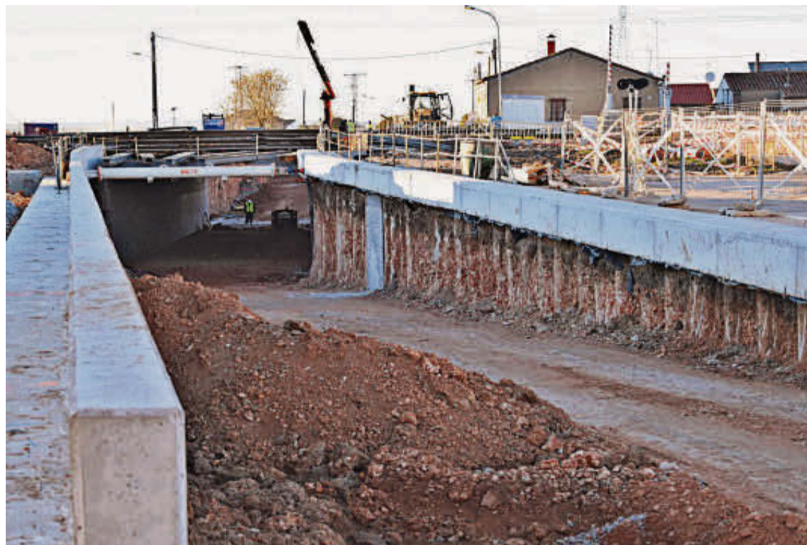
El túnel bajo las vías en el paso a nivel de Gomecello con el acceso de más de 200 metros de longitud. | EÑE
