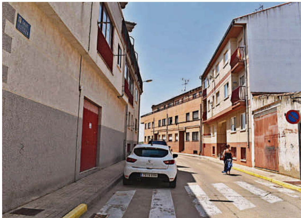
La calle Escoda es una de las que se renovará con plataforma única y prioridad para los peatones. | EÑE
