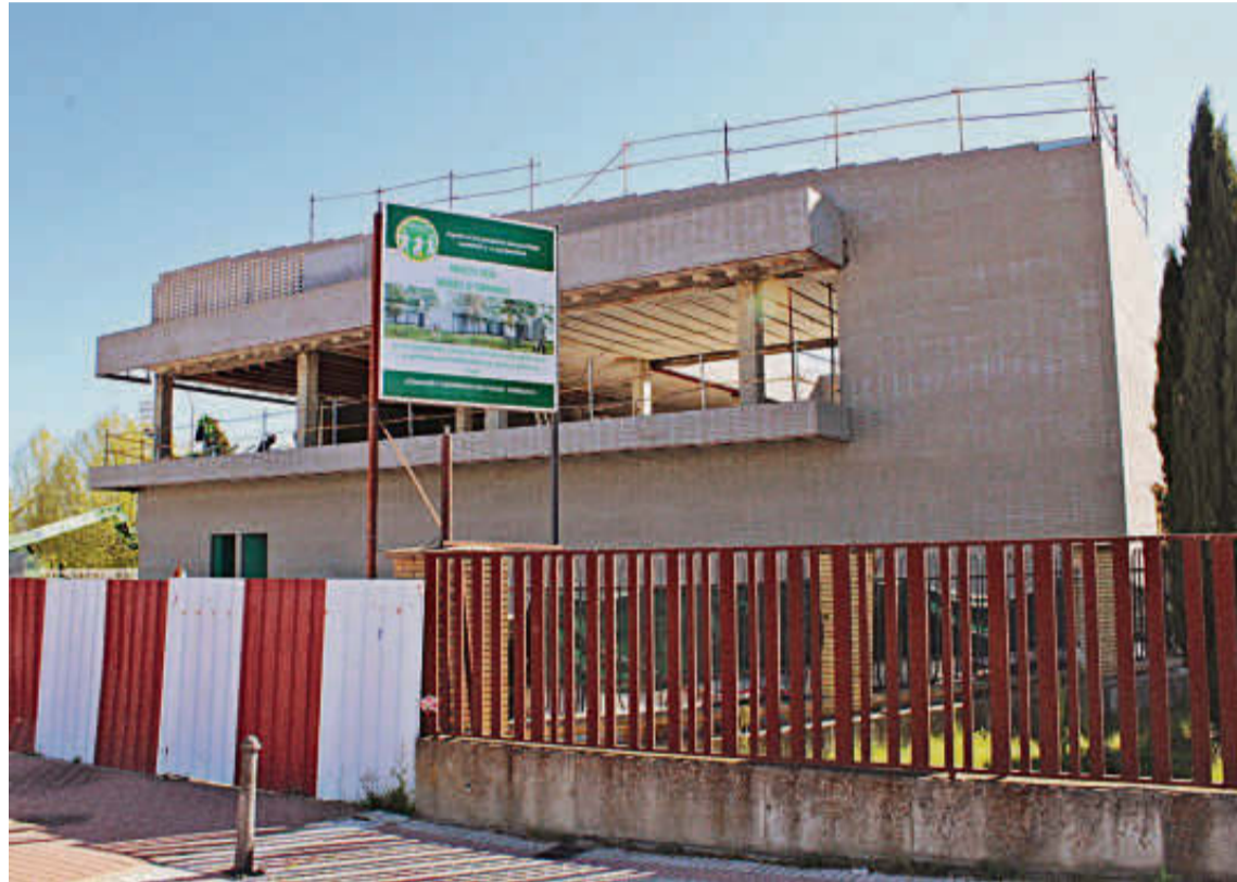
La obra de las nuevas instalaciones de ASPACE junto al estadio Helmántico. EÑE
