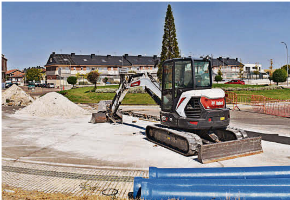
Trabajos para renovar la tubería general de la red de agua de Villares de la Reina. EÑE
