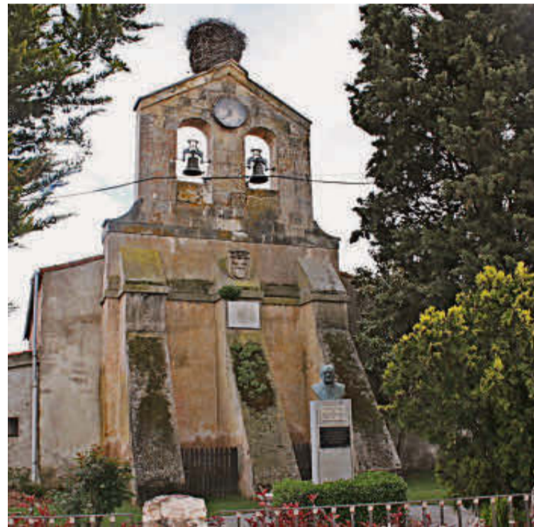
Estado actual de la parroquia de Aldeatejada. | EÑE
