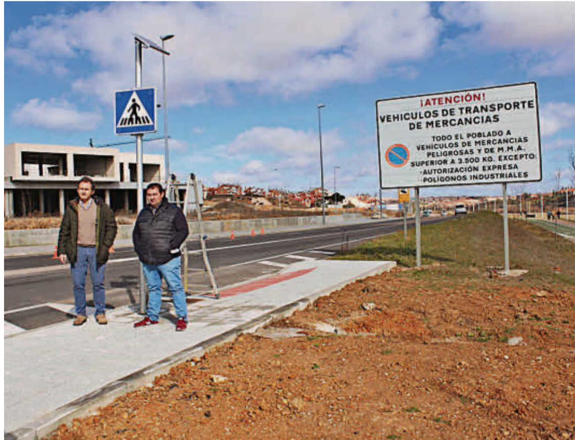
Enrique García y Francisco Javier Martín en el punto de instalación del nuevo paso seguro para peatones. | EÑE
