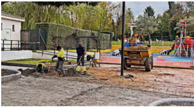
Los operarios durante la remodelación del acceso al parque. EÑE
