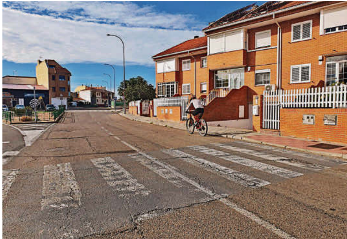
Un ciclista por el tramo de la avenida José García Santos de Villares que ahora se renovará. EÑE
