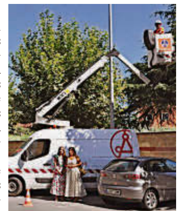
Inicio de los trabajos. EÑE
