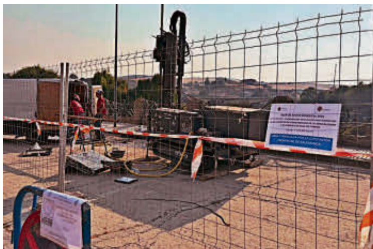
Trabajos para realizar el estudio geotécnico en Alba. ENE
