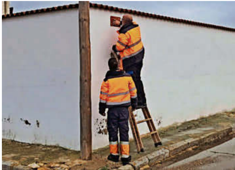
Operarios instalando placas de cerámica en Torrejón de Alba. EÑE
