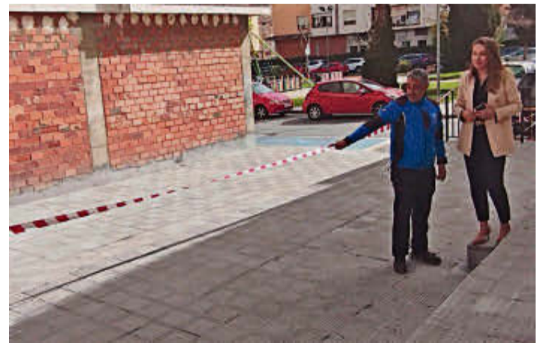
La edil Marta Labrador en la visita a las obras de la plaza. EÑE
