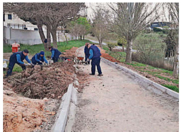
Los alumnos trabajando en la creación del paseo peatonal de Valdehigal. | EÑE
