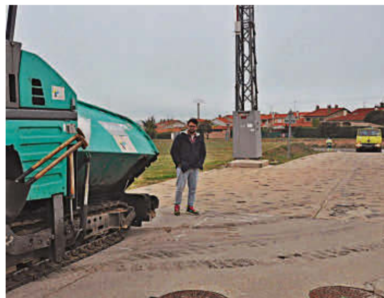
El alcalde, Guillermo Rivas, en la pavimentación. | EÑE
