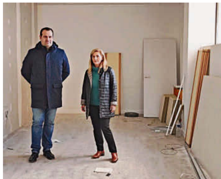
El regidor David Mingo y la edil Juani Rubio, en las obras del centro. EÑE
