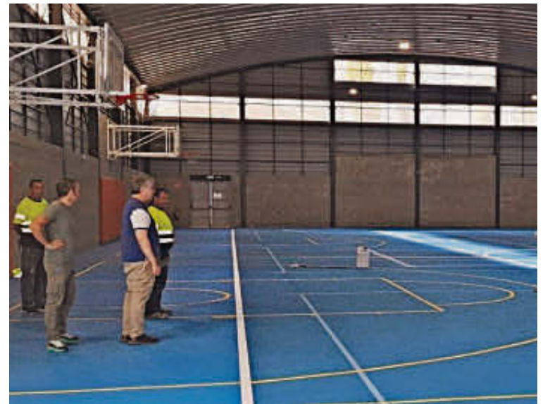
Renovación del suelo de la pista multideporte cubierta de Carbajosa. EÑE
