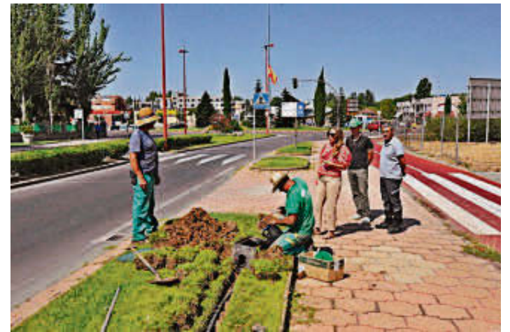
La edil de Parques y Jardines, Marta Labrador, en la obra. EÑE
