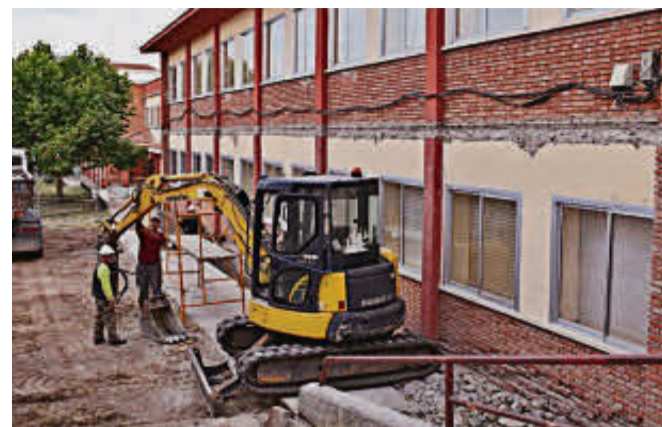
Las obras en una de las fachadas del IES Leonardo da Vinci. | EÑE
