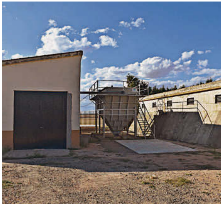
Las obras en la Estación de Tratamiento de Agua Potable de Cabrerizos. | EÑE
