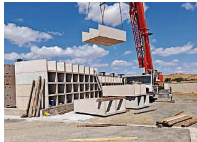
La instalación de los nuevos nichos en Alba de Tormes. EÑE
