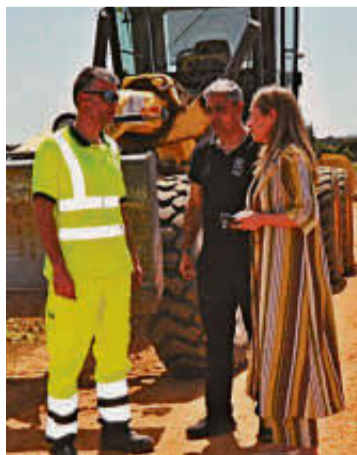
La edil Marta Labrador en uno de los caminos que se están nivelando. EÑE
