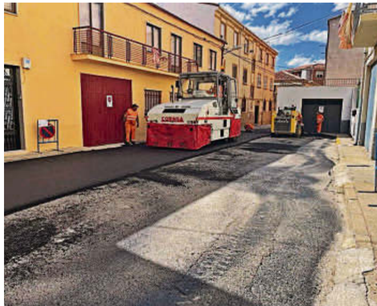
Los trabajos de pavimentación ya se están desarrollando. | EÑE
