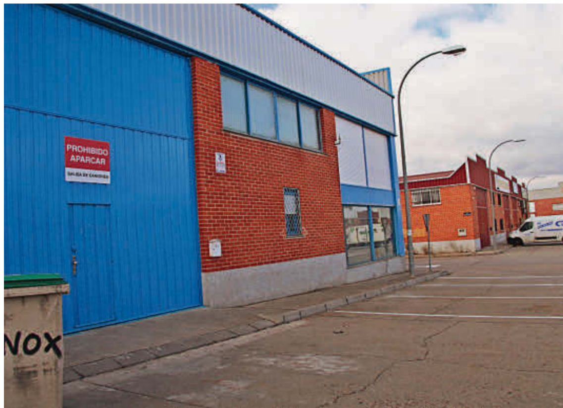
Una prohibición de aparcar con aviso de salida de camiones, pero sin vado, en el polígono de Villares. | FOTOS:EÑE
