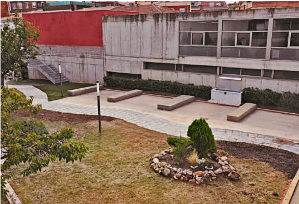
La nueva imagen de la zona exterior junto al Espacio de Innovación de Santa Marta. EÑE
