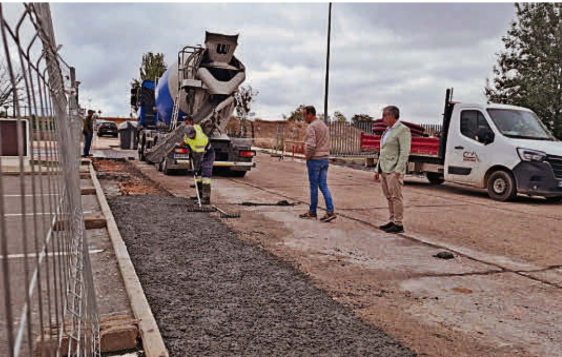
Las obras de adecuación y mejora de accesibilidad en la calle Villares de Carbajosa de la Sagrada. EÑE
