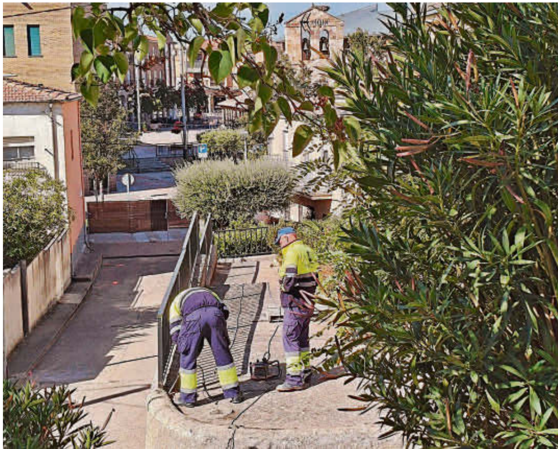
Dos operarios trabajando en una de las zonas en las que se va a ejecutar la mejora. EÑE
