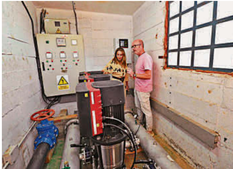
La concejala de Obras, Marta Labrador, visita el nuevo bombeo. EÑE
