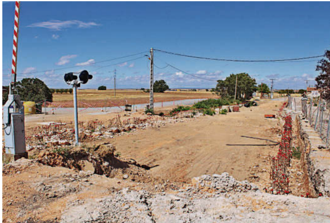
La obra del paso a nivel de la entrada de Gomecello, sin trabajadores en la mañana de ayer. | EÑE
