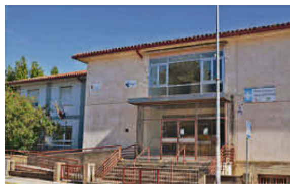
Futuro emplazamiento del CIS de Miróbriga. D. S.
