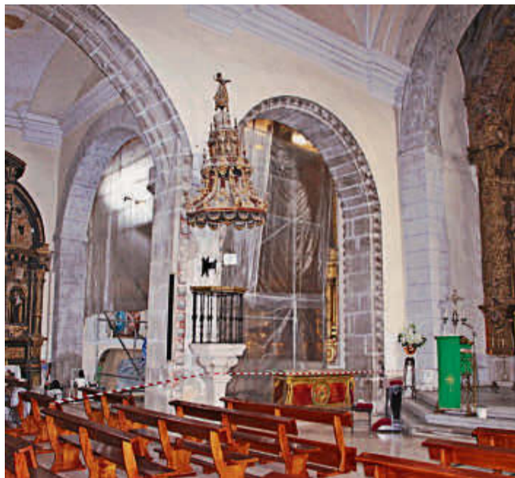
Andamiaje y protecciones del espacio destinado a la obra. FOTOS: JH
